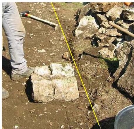
Nun kann das Legen der Fundamentsteine beginnen. Die grossen Fundamentsteine werden perfekt nach der Schnur ausgerichtet und ihre Oberfläche leicht gegen die Mauermitte geneigt. Die Zwischenräume zwischen den Fundamentsteinen werden sorgfältig mit kleinen Steinen ausgemauert und ausgekittet. Diese Keilsteine werden einzeln von Hand eingebaut und nicht geschüttet.
